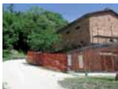
Lavori in corso a Rad'art
