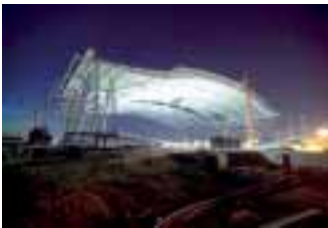
Il Terminal 5 dell'aeroporto londinese durante i lavori
