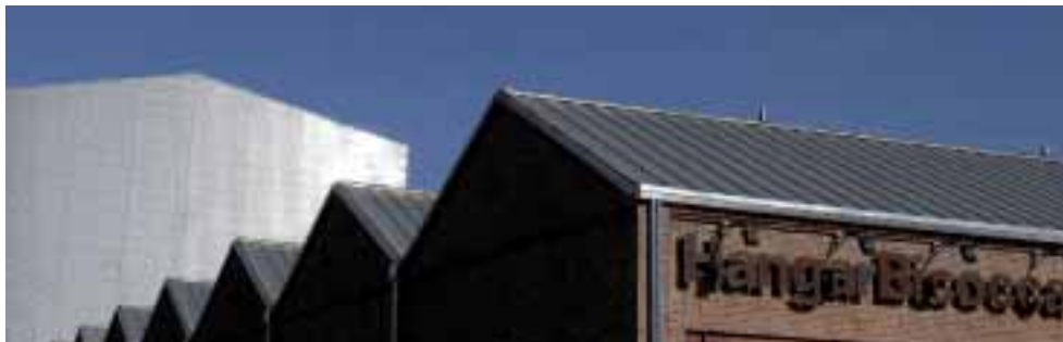
qui a sinistra: esterno Hangar Bicocca sotto: Chiara Bertola in basso nel box: Anthony McCall - Between You and I , 2006
